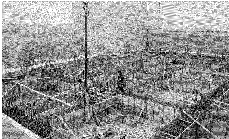
Alcune immagini di cantieri edili
